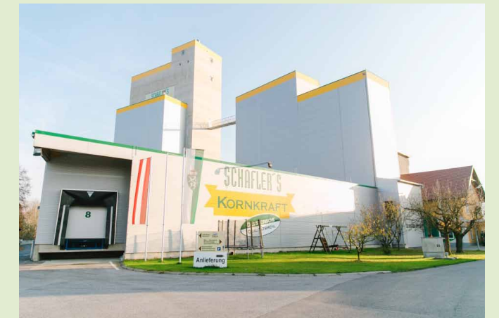
Kornkraft Schafler - Firmengelände
