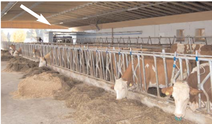
Stallerweiterung mit Melkroboter (Pfeil)
