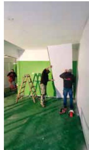
In rund 2 Monaten Bauzeit wurde ein neuer Industrieboden eingebracht, die Wände erhielten eine Paneelverkleidung, Elektro- und Sanitärinstallationen wurden erneuert und das Problem mit der Abluft gelöst. Somit können wir nun auch in diesem Praxisbereich hygienetechnisch einwandfrei und sauber arbeiten.
