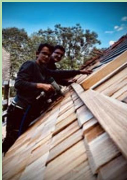
Dach abgerissen, eine Stützwand neu errichtet, das Holz im eigenen Schulwald geschlägert und laut Holzauzug abgelängt und mit mobilen Bandsägen aufgeschnitten. Danach wurde der Dachstuhl wieder errichtet und nun mit Lärchenschindeln gedeckt. Und das ausschließlich im Projektunterricht der 2. und 3. Jahrgänge sowie im Praxisunterricht.
