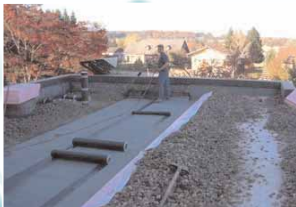
Bild oben: Flachdachsanieung Bild unten: Fenstertausch in den Klassenräumen
