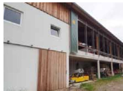
Durch das Gelände war ein Güllekeller die effizienteste Lösung
