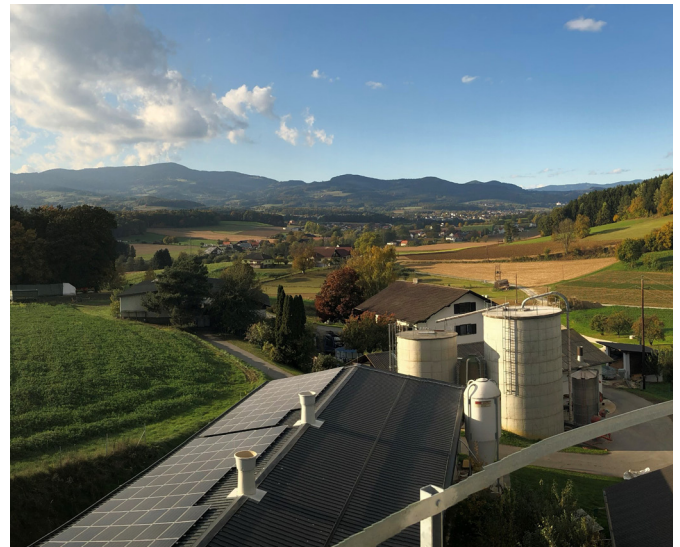
Auf dem Dach des Hühnerstalls liefert eine PV-Anlage Strom
